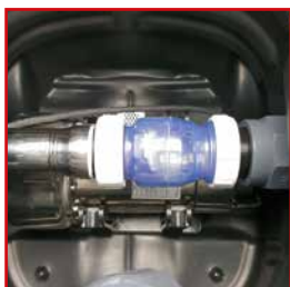
Rückschlagventil RSK und Entleerungspumpe
